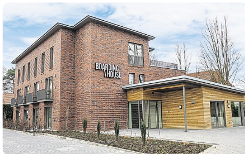
Gerade fertiggestellt: das Boardinghouse für Timber in Lingen.
