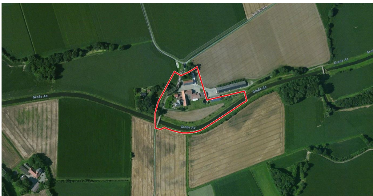
Abbildung 1: Luftbild Teilbereich 51.2 mit rot umrandeten Geltungsbereich unmaßstäblich (Quelle: www.bing.com/maps/ )
